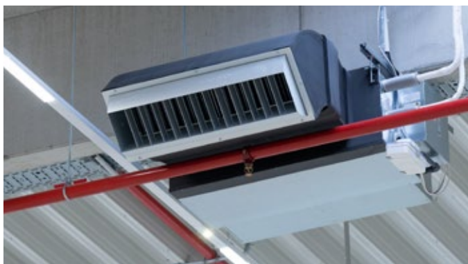
Vyústění vzduchu s tryskami
