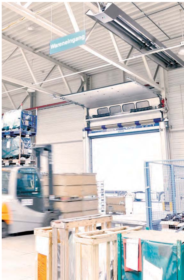
Plynové vytápění - tmavý infrazářič
